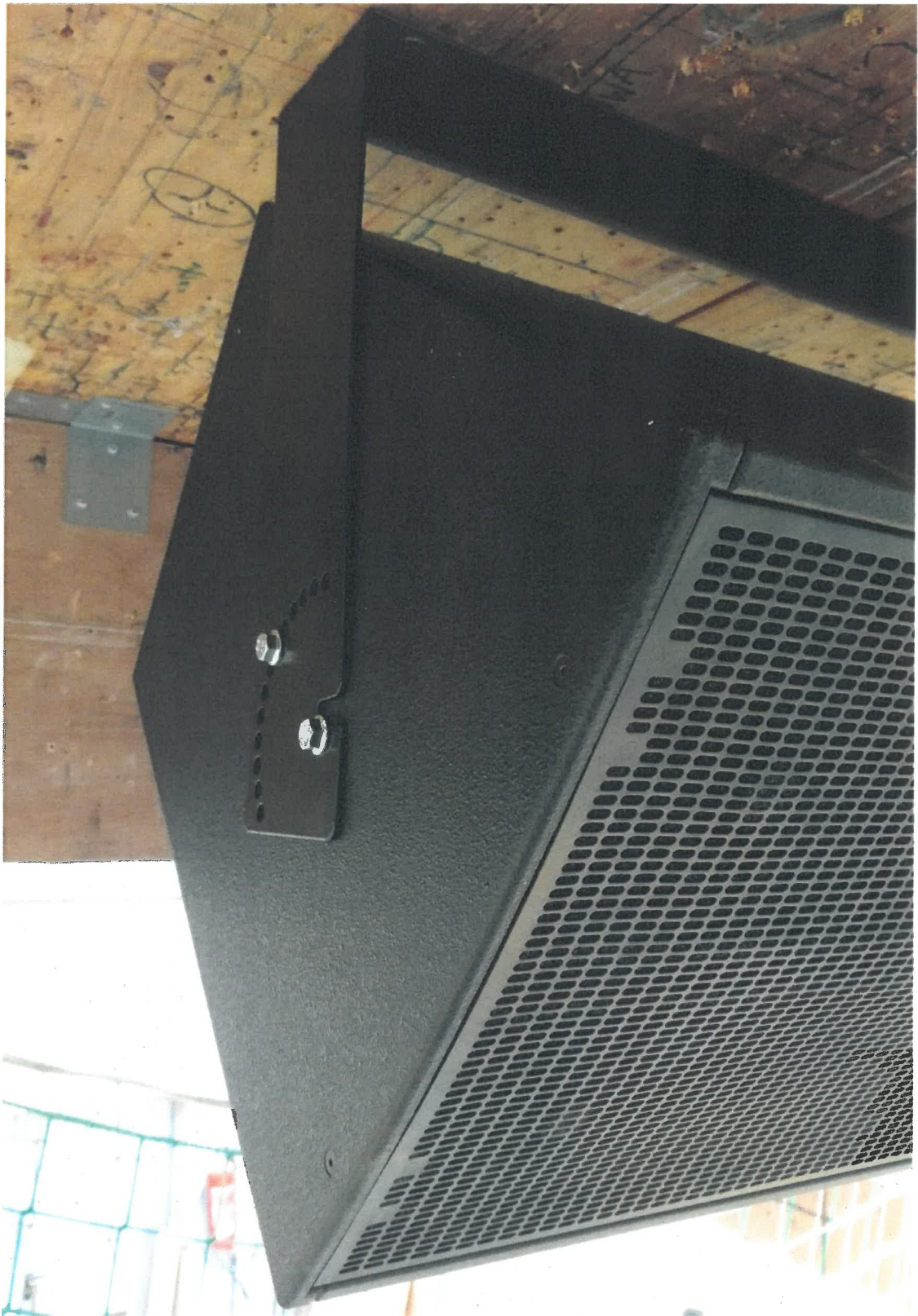
Bild 2: Detail Befestigung des Bügels Lautsprecher „FINEO FO 15 (1008001) mit Bügel (1008030-01)“
